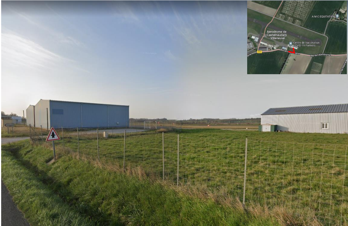
Figure 1- Vue depuis la RD33 (Route de l'Aérodrome), qui marque la limite Sud de l'Aérodrome
