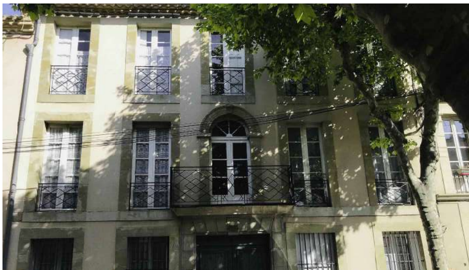
Immeuble rue Riquet, pierre de taille et moellons enduits, composition symétrique avec balcon sur travée centrale
