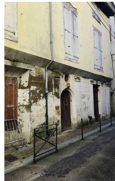
Maison rue du collège avec pilastre ionique
