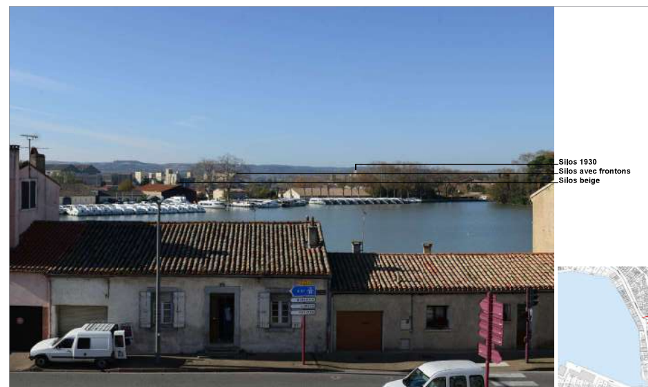
Vue des silos depuis la rue depuis la Haute Baffe
