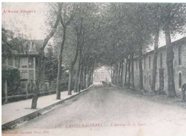
L'avenue de la Gare
