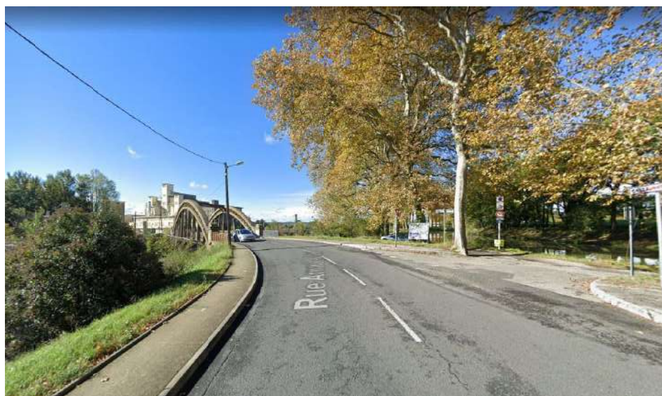
Co-visibilité entre le canal du Midi et l'ensemble pont et silos
