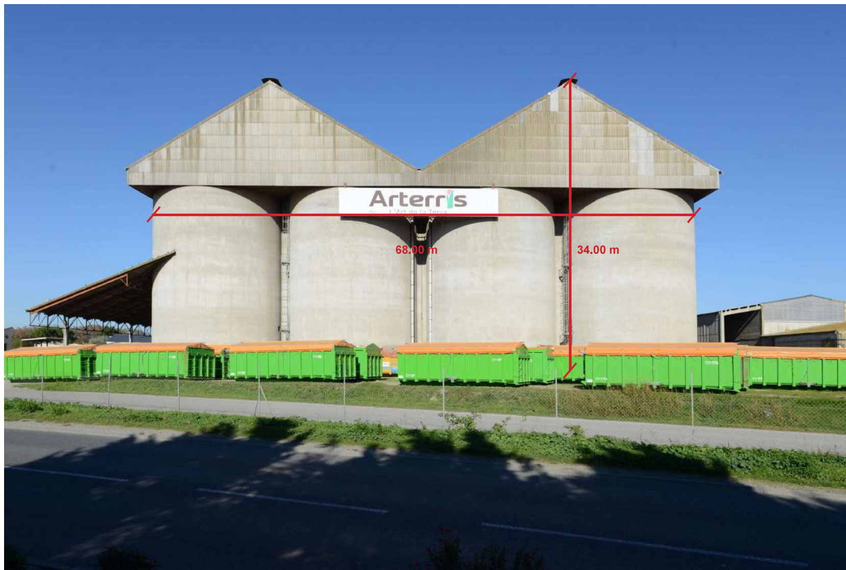
Silos avec frontons (Dimensions approximatives)
