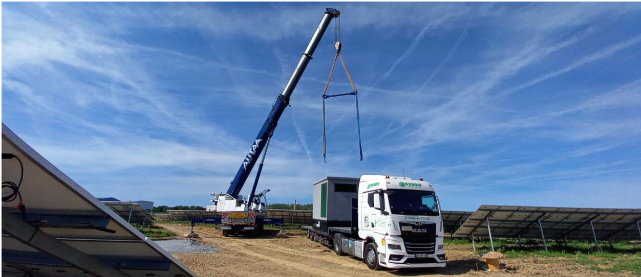
Figure 19 : Installation d'un local technique
