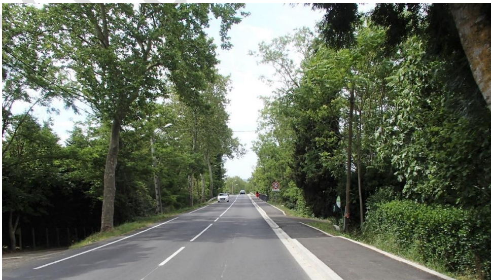
Entrée de Castelnau par la RD 33
