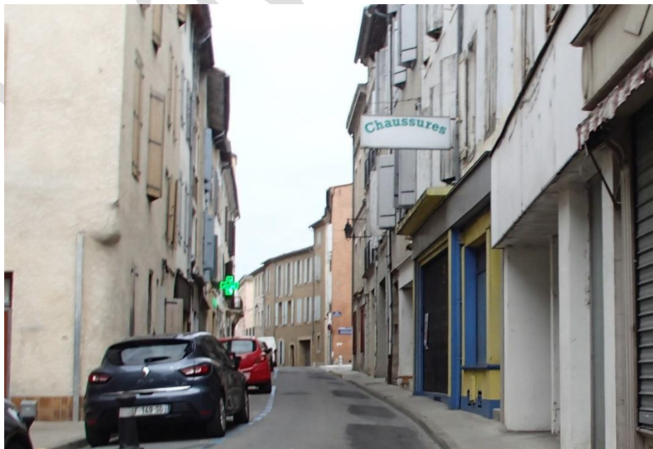
Enseigne perpendiculaire dont la saillie est trop importante (infractions au RNP : trop haute, et dépassement de plus 10 % de la distance séparant les 2 alignements)
