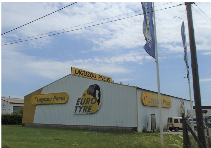
Une enseigne sur toiture illégale qui n'est pas constituée de lettres découpées
