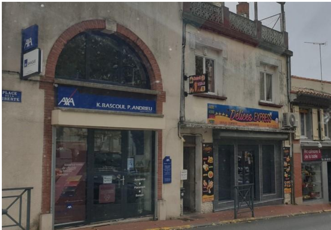
L'enseigne de gauche s'inscrit dans l'ouverture (arcade) de la façade L'enseigne de droite flotte sur le mur : elle n'est alignée ni en hauteur ni en largeur sur un élément de composition de la façade
