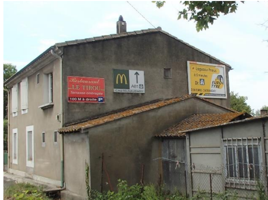
Plusieurs dispositifs sur un mur
