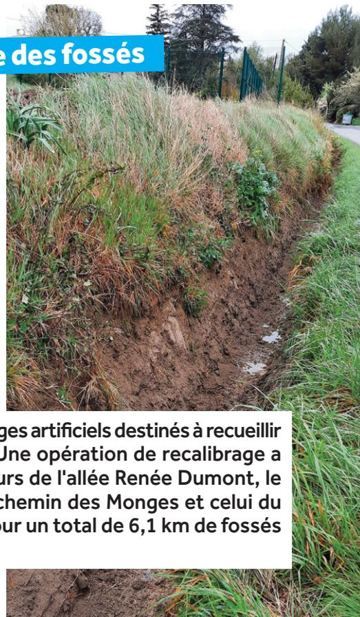
Les fossés sont des ouvrages artificiels destinés à recueillir les eaux d'écoulement. Une opération de recalibrage a été menée sur les secteurs de l'allée Renée Dumont, le chemin des Loubats, le chemin des Monges et celui du Cabanou (aux Crozes) pour un total de 6,1 km de fossés traités.
