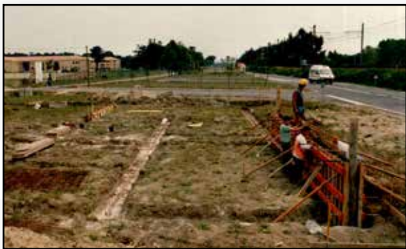
1986 : Les travaux se poursuivent le long de la route de Pexiora. L'ossature du régiment est vue par ceux qui y passent. Déjà là, une place d'armes flambant neuve avec un nouvel état-major fonctionnel. La caserne Lapasset est rétrocédée à la ville en décembre 1991.
