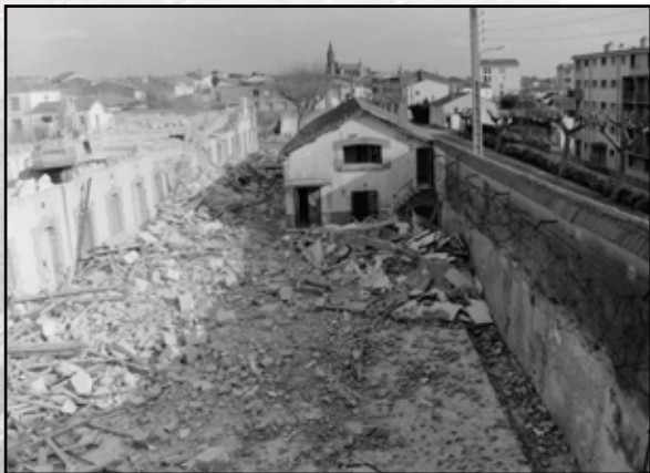
1997 : Chantier de démolition de la caserne Lapasset.
