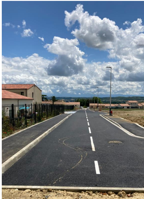
Travaux d'extension de la Rue Louis Naudinat
